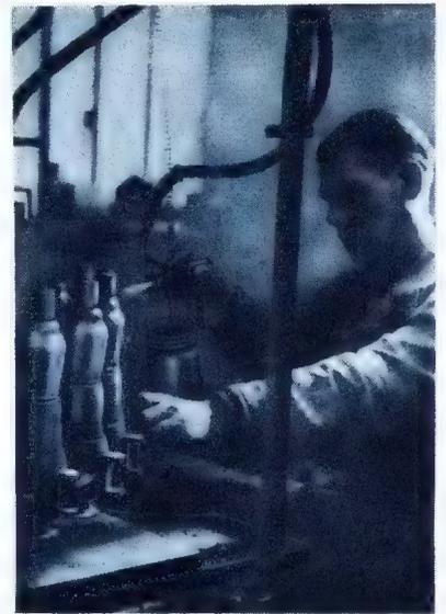
Die Radoröhre erhält mit der Spritzpistole einen „Metallmantel“, der sie vor störenden äußeren Einflüssen schützt. Bevor es soweit kam, durchlief sie viele komplizierte Fabrikationsphasen und Kontrollen. Tunggram Radoröhren stellen das Beste dar, das neuzeitliche Radiotechnik zu leisten vermag.
